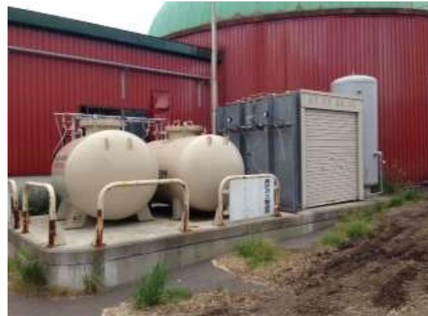
重量約2t、0.7MPaで50-60 Nm<sup>3</sup>の精製バイオメタンが入る
