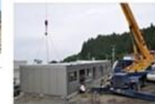
建設中の様子
